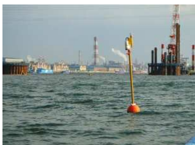
写真-2 通信制御装置
