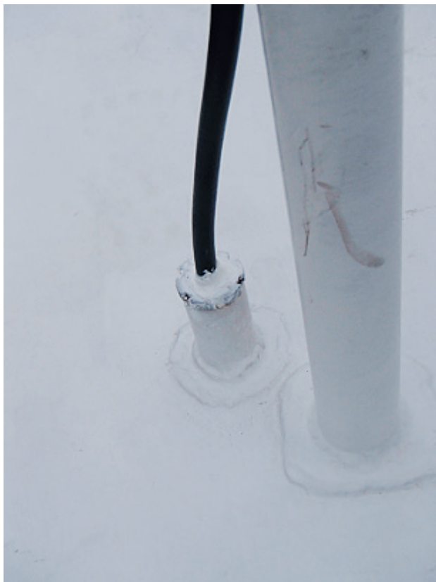
Photo 6. Cable gland for antenna cable on the roof of S/V Kurushima. 写真6. 測量船「くるしま」の観測室上部の貫通金物。
