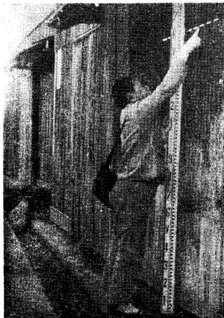
周参見に於ける津浪の痕跡 津浪の高さ3.61メートル (ML上3.94メ ートル) 地面の高さML上2.33メートル
