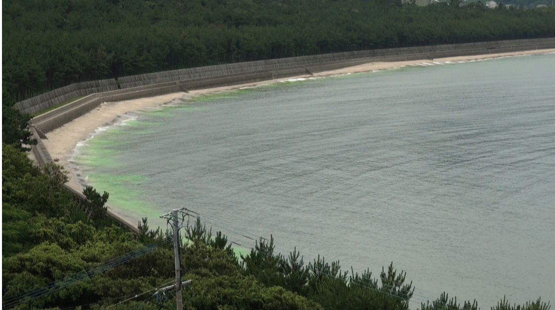
配埼付近にあるマンションの屋上から撮影した調査の様子（平成 25 年 6 月 27 日 10 時 38 分頃）
