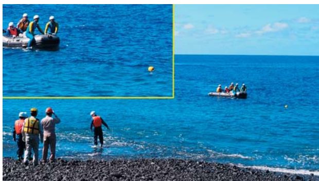
Photo 7. Anchor buoy in the sea. 写真7. 海上に設置したアンカーブイ.
