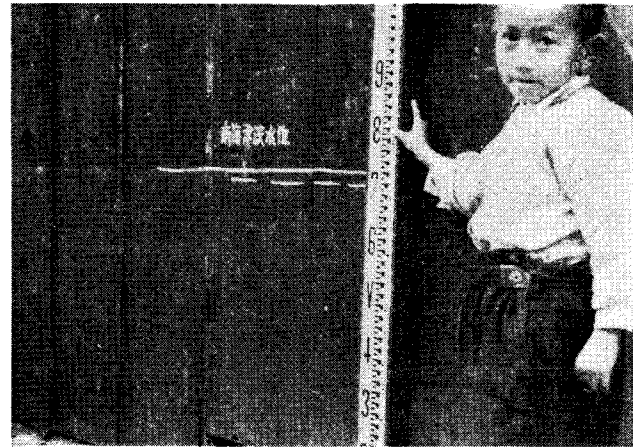
津浪の高さ3.28メートル (ML上3.60メートル) 地面の高さML上2.99メートル
