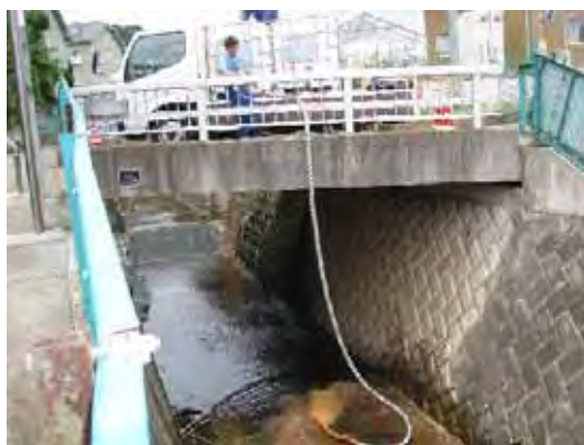
津久井川 EM放流状況
