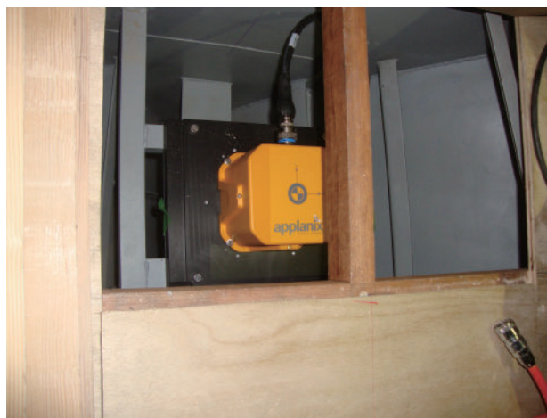
Photo 26. Position and orientation system IMU 写真 26. 測位動揺計測装置 IMU
