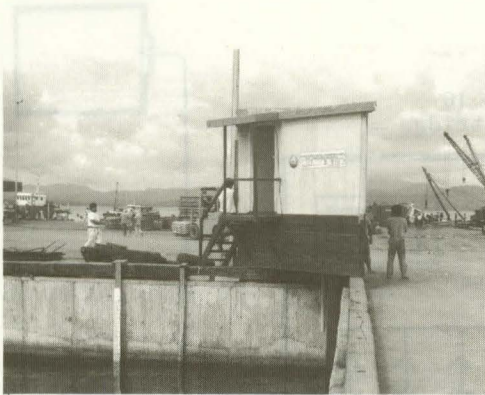
写真1 プエルトプリンセサ験潮所全景
